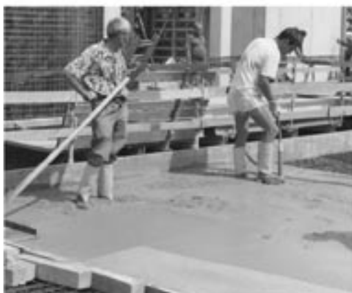
Pokládka betonu
