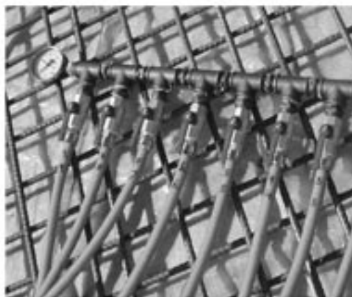
Tlaková zkouška (při přivádění betonu musí být stále pod tlakem!)
